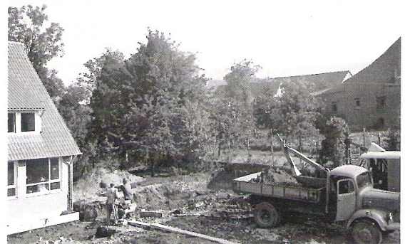
... und die Tankgrube zugeschüttet.
