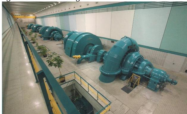
Die vier Maschinensätze im Krafthaus werden durch die herabstürzenden Wassermassen angetrieben.
